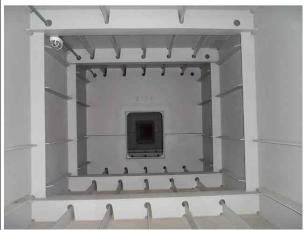
거더 내부 전경
