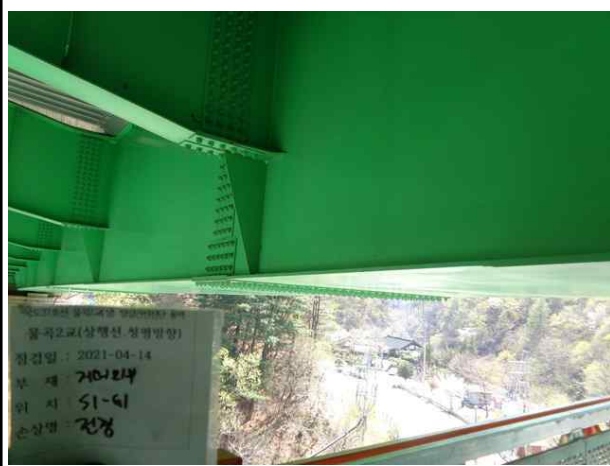
거더 외부 전경
