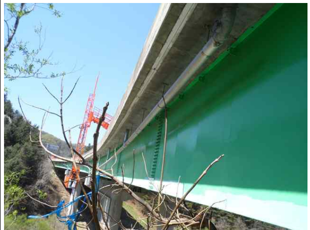
외측 배수관 전경
