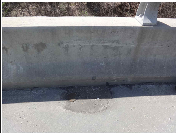
상부 배수구 전경
